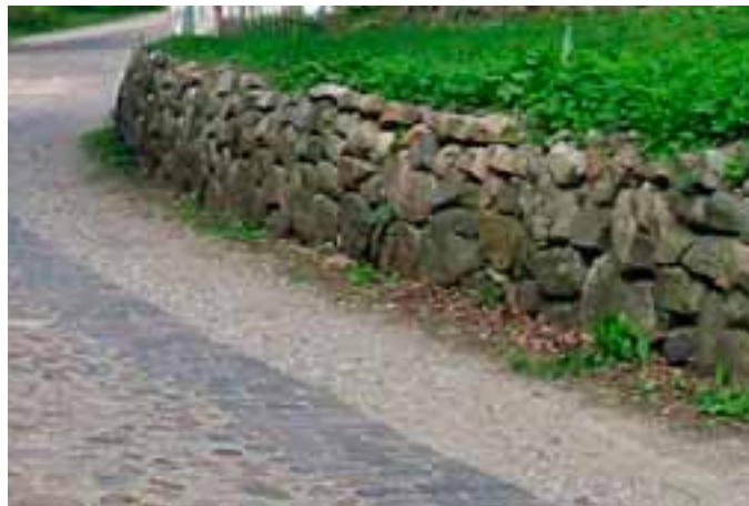
Stensætning og slidstærk belægning
