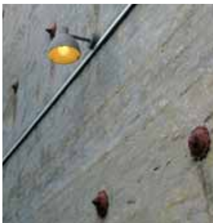
Spændbånd og betonpuds
