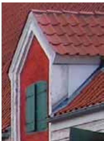
Mur, tegl og træ
